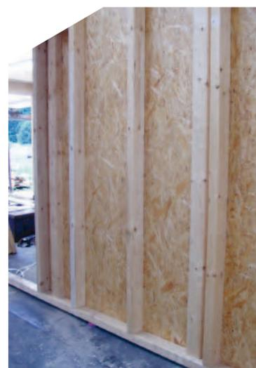
Trockenbau-Unterkonstruktion mit einseitiger Beplankung durch Holzwerkstoffplatten
