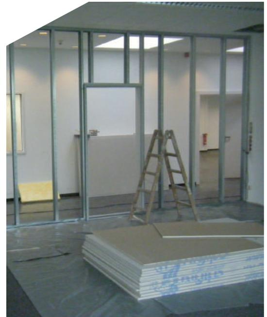
**Metalständerwerk und Gipskartonplatten**
