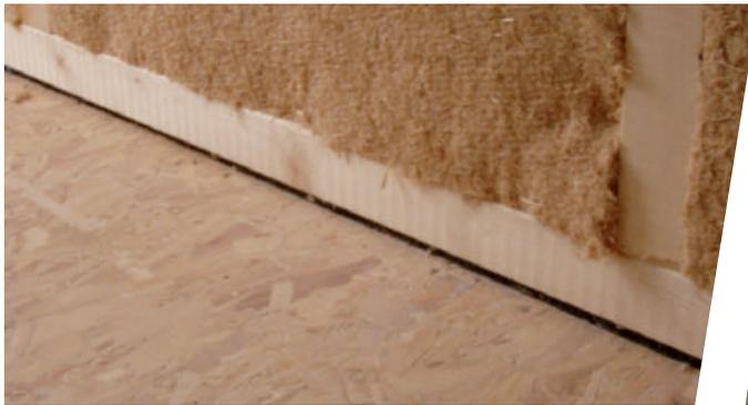
Schallentkopplung zwischen Rohfußboden und Schwelle der Unterkonstruktion
