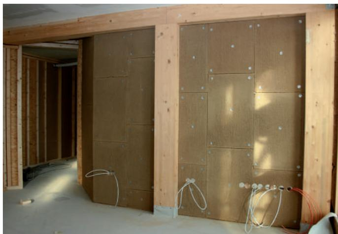
**Innenwandkonstruktion aus Holzständerwerk mit OSB, Lehmbauplatte und Zellulosedämmung**
