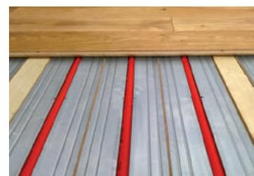
Fußbodenheizungssystem auf Holzkonstruktion
