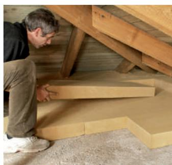
Anwendung einer Holzfaserdämmstoffplatte
