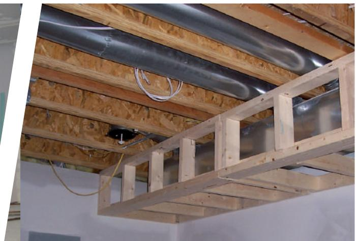
Holzunterkonstruktion für einen Lüftungskanal
