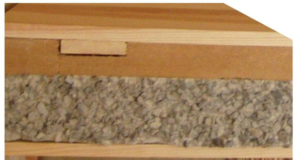
**Fußbodenaufbau im Geschosswechsel mit Kalkschotter, Holzfaserdämmplatte, Unterkonstruktionsholz und Bodendiele**
