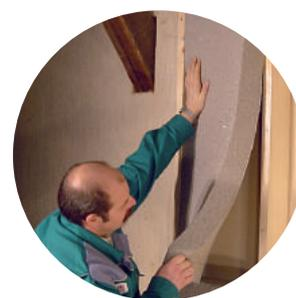
Anwendungsbeispiel: Dämmung einer Trockenbauwand mit flexiblen Dämmmatten
