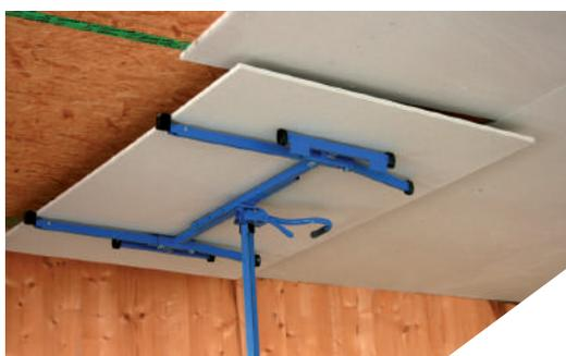
**Zweilagige Beplankung einer Decke mit Holzwerkstoffplatte und Gipsfaserplatte auf Trockenbauunterkonstruktion**
