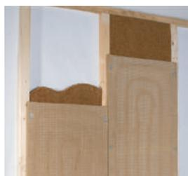
Wandheizungselemente auf Holzunterkonstruktion mit Hanfdämmung
