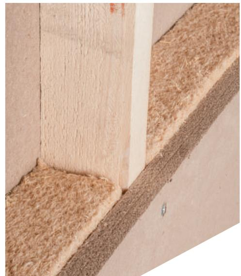
**Trockenbaukonstruktion mit Holzständerwerk. Dies wird beidseitig anschließend mit Holzfaserplatten zweilagig beplankt und der Hohlraum mit Holzfaserdämmmatten befüllt.**
