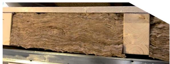
**Fußbodenaufbau mit Holzfaserdämmplatte, Gipsfaserplatte und Balkenhohlraumdämmung**
