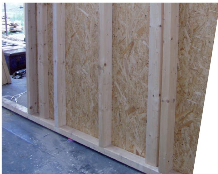
Unterkonstruktion aus Holz mit einseitiger Beplankung aus OSB-Platten und Schallentkopplungsstreifen
