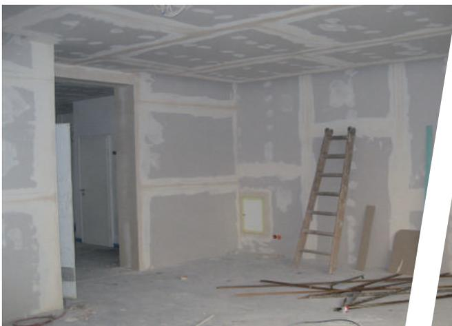
Innenwände und Deckenbekleidung: Gipskarton, gespachtelt und armiert
