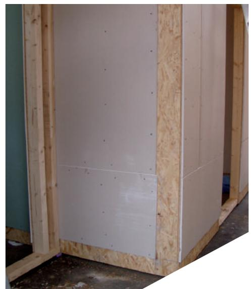
**Zweilagige Beplankung: Wand mit Holzwerkstoffplatte und Gipsfaserplatte auf Trockenbauunterkonstruktion**
