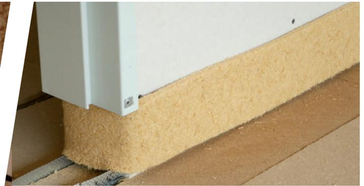
Randdämmstreifen zur Schallentkopplung zwischen Trockenbauwand und Fertigfußboden
