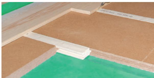
Dielenverlegung auf Holzfaserdämmplatten mit Lagerhölzern
