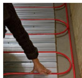
Verlegung eines Trockenbau-Fußbodenheizungssystems
